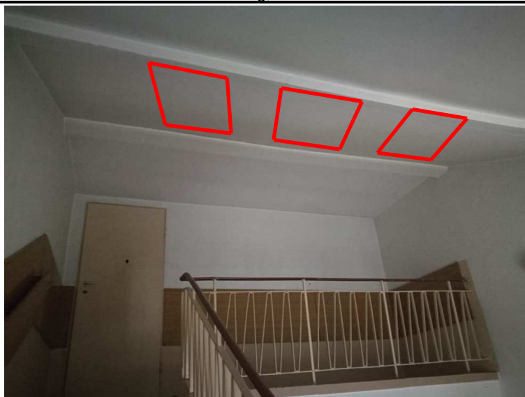
Oddymianie: 3 okna VELUX SK08 o wym. 1140 x 1398
