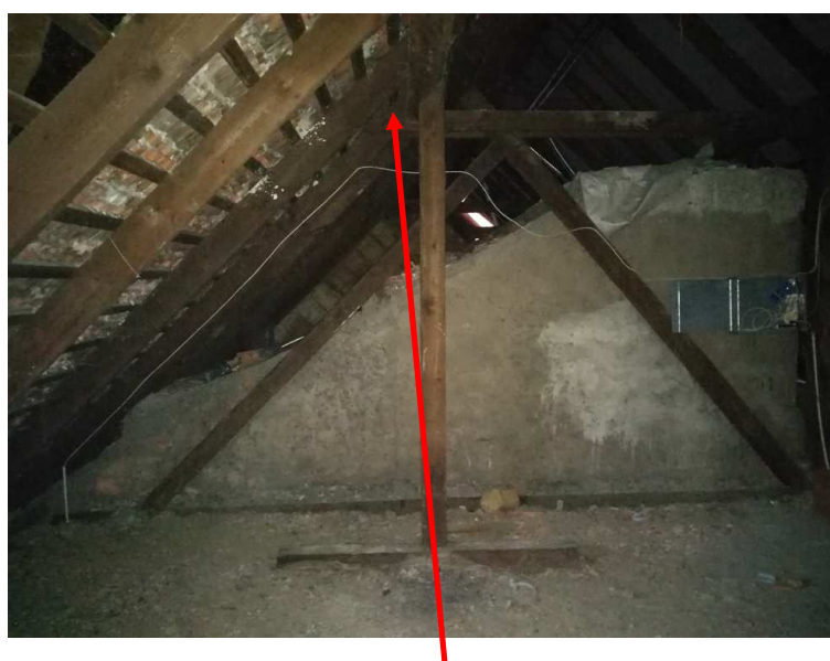
Oddymianie: Montaż okien oddymiających w połaci dachu (3 okna VELUX SK08 o wym. 1140 x 1398), w szczycie klatki schodowej. Wykonanie obudowy klatki schodowej w klasie REI60 do połaci dachu, zgodnie z odrębnym projektem budowlanym.
